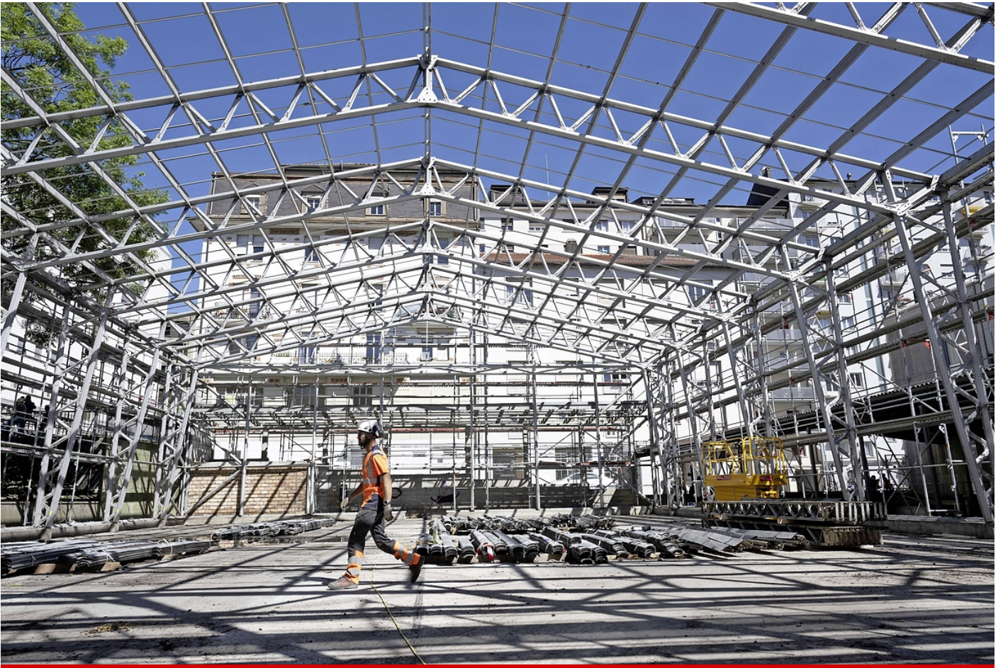
Halle métallique Cafag; ouvriers démontant la structure métallique et portraits de responsables du chantier. Charly Rappo
